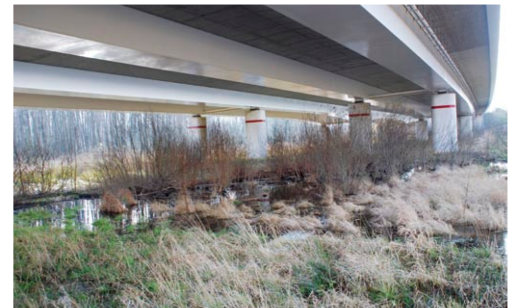
Abb. 10: A20-Querung über die Wakenitz. Das ca. 300 m lange Viadukt wird intensiv von Rot-, Schwarz- und Rehwild genutzt.
