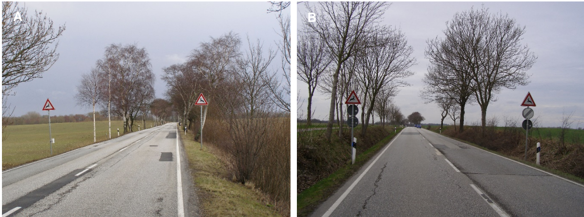
Abb. 6-29: Teststrecke B202_EH. A: Beginn der Teststrecke an Reviergrenze Farve-Ehlerstorf, Blickrichtung Osten (Ehlerstorf), am linken Schild ist das Seitenradargerät angebracht, B: Ende der Teststrecke, Blick zurück nach Osten (Farve).
