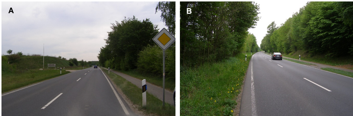
Abb. 6-44: Teststrecke L298_LW. A: Blick nach Südwesten auf Höhe des Kieswerkes, B: Blick nach Südwesten im weiteren Verlauf nach Kieswerk.
