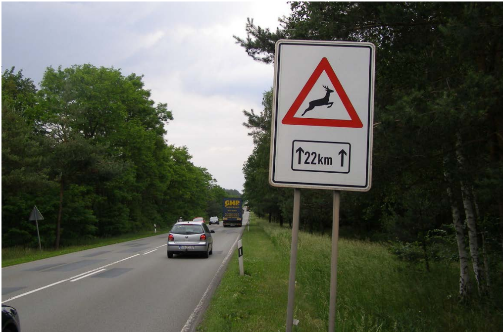
Abb. 4-29: Warnung vor Wildwechsel auf 22 km Länge an der B 189 zwischen Magdeburg und Stendal. Trotz Einmündungen bzw. Kreuzungen anderer Straßen wurde die Warnung auf den 22 km nicht wiederholt. Zudem ist hier das für eine Aufstellung am linken Straßenrand vorgesehene VZ 142-20 aufgestellt. Bei korrekter Aufstellung springt der stilisierte Rehbock vom Straßenrand zur Straßenmitte, also von außen nach innen, nicht wie hier gezeigt von innen nach außen. Auch wenn eine Warnung hierdurch grundsätzlich nicht verhindert wird, zeigt es dennoch die Leichtfertigkeit, mit der selbst die zuständigen Stellen mit dem Warnhinweis umgehen.
