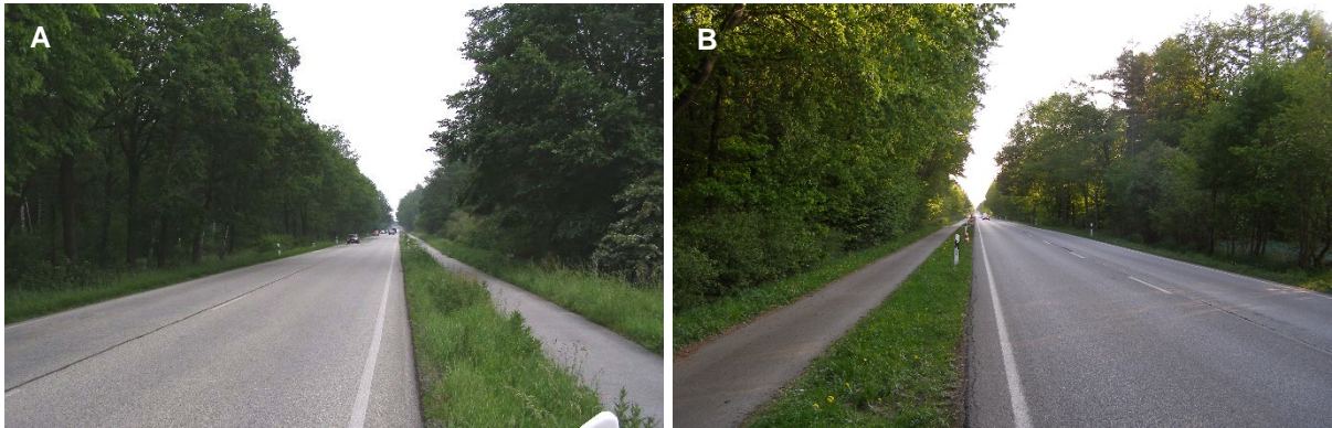
Abb. 6-37: Teststrecke B432_GN. A: Blick nach Nordosten in Richtung Groß Niendorf, B: Blick nach Südwesten.
