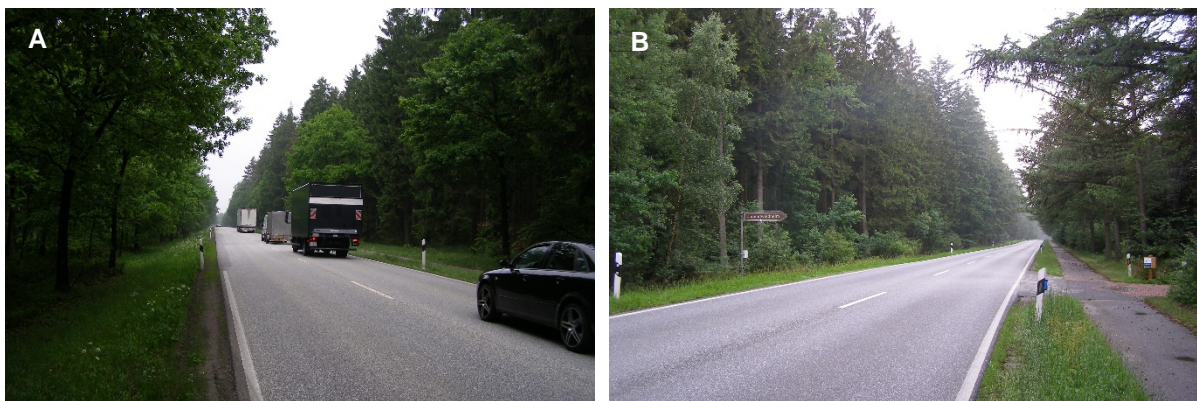
Abb. 6-33: Teststrecke B206_SF. A: Blick nach Osten, in Richtung Bad Segeberg, B: Blick nach Westen
