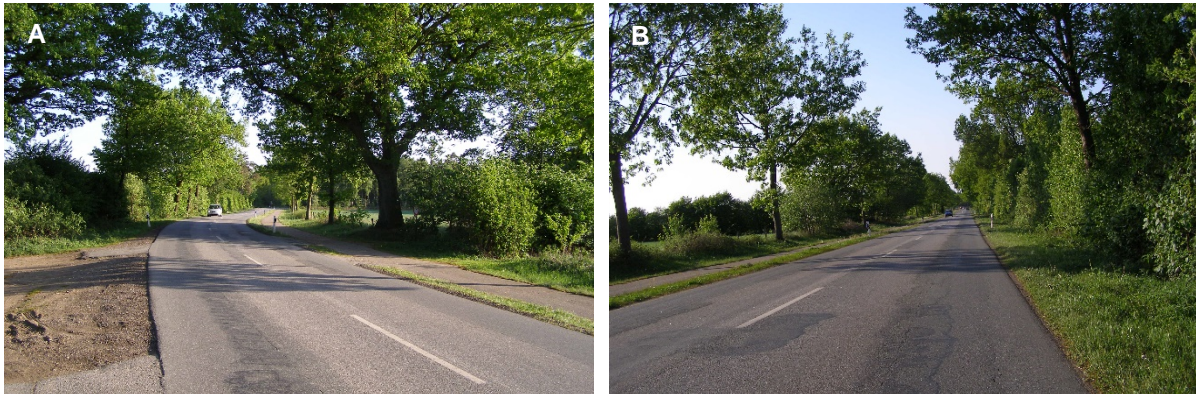
Abb. 6-47: Teststrecke K073_WA. A Blick nach Süden auf den Anfang der Teststrecke.; B: Blick nach Norden in Richtung Wahlstedt.
